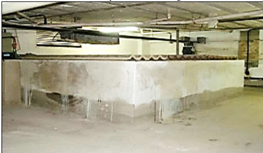
Figura 61 – Foto do sistema de reaproveitamento da água do destilador do CPqAM
